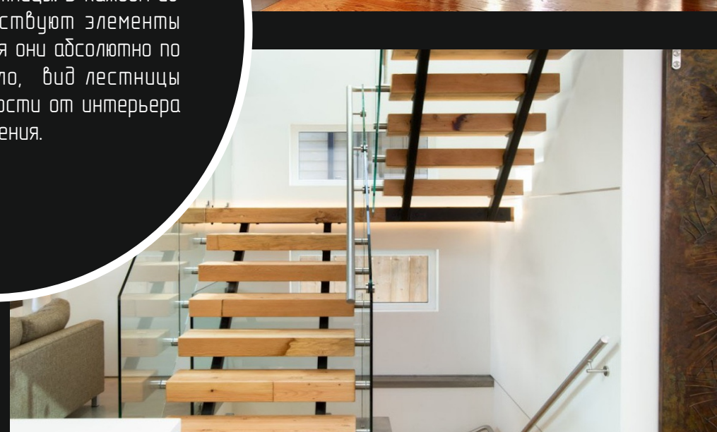
на металлическом каркасе
